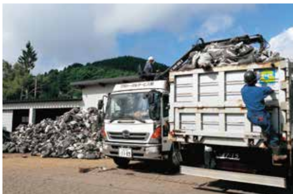
廃プラのトラックへの積み込み作業
