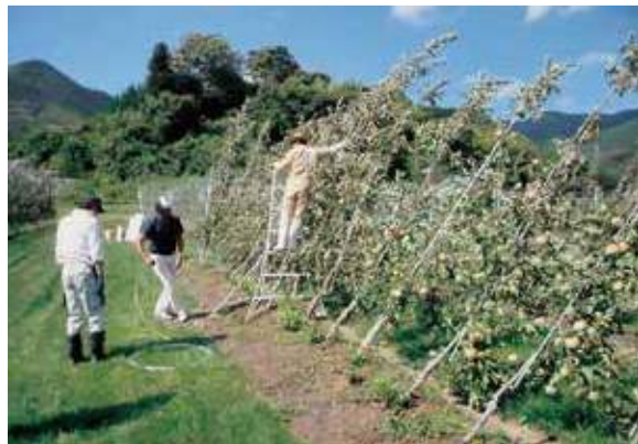
台風で倒れたリンゴの木と支柱の復旧作業
