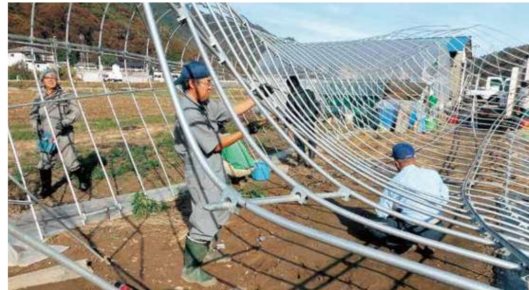
ビニールハウスの骨組みの撤去作業をするJA職員(上田市東内)
